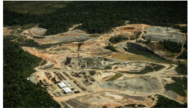
Construção da usina Teles Pires, no rio Teles Pires. Com cinco barragens o complexo hidrelétrico no rio está afetando a vida das pessoas na região. O Teles Pires corre ao lado do rio Juruena e forma o rio Tapajós. (Foto: Thiago Foresti/Forest Comunicação).
