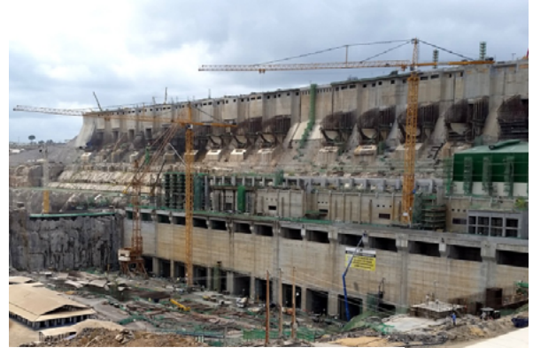
Obras da Usina Hidrelétrica de Belo Monte. (Foto Wikimedia Commons).
